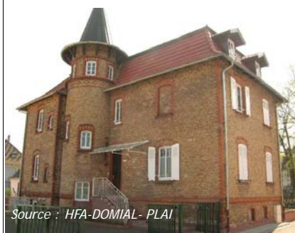
Acquisition et amélioration de deux logements en PLAI dans la commune d'Haguenau
